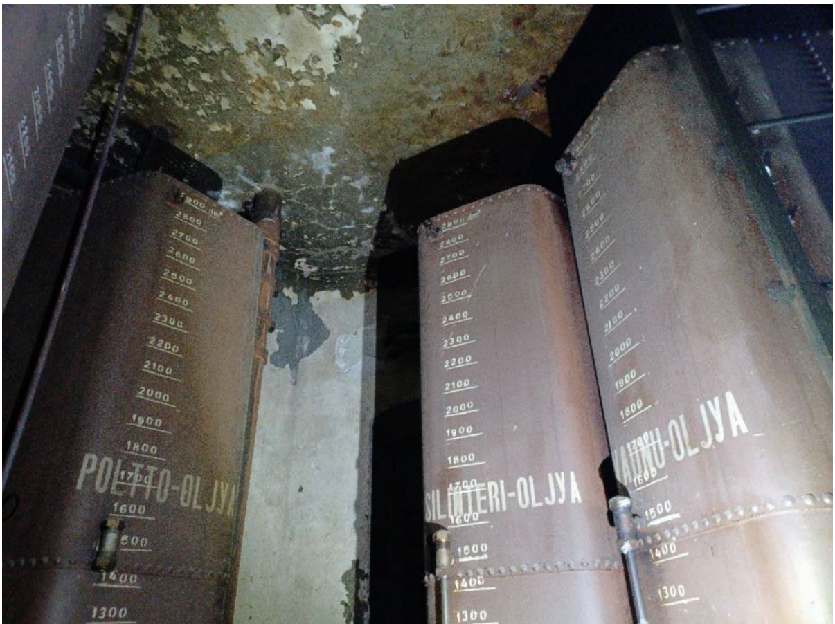
Kuva 82. Kuvia vesitornista, jossa on käyttötarkoituksen muutoksen jälkeen säilytetty öljyä.
