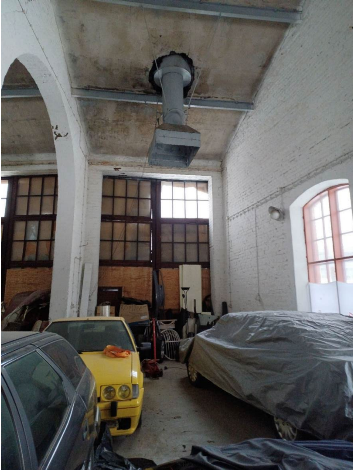
Kuva 105. Tilassa on betonilattia ja tiiliseinät. Puisten, alkuperäisen mallin mukaisten tallinovie (1 ja 2) suuret, moniruutuiset ikkunat on peitetty vanerilla ilkevällä vuoksi. Ikkunoiden sisäpuutteet vaihdettu 1-ruutuisiksi. Pyöreät valaisimet todennäköisesti alkuperäiset, ja toimivat edelleen.
