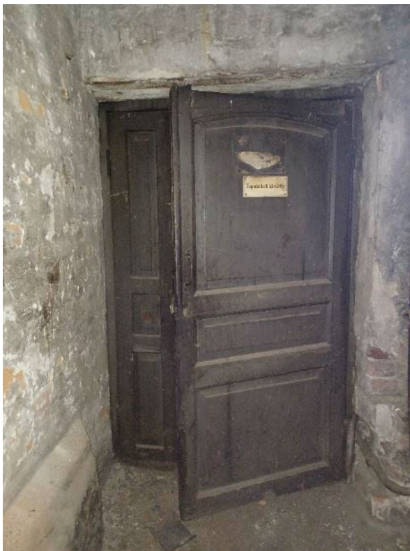
Kuva 84. Entisen vesitornin sisäänkäynti tila nro 9 puolelta.
