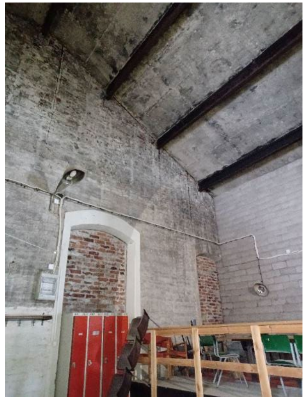
Kuva 101. Vasemmanpuoleisessa kuvassa näkyy laajennusosan betonipalkkeja ja oikealla näitä vanhempaa perua olevia I-palkkeja sisäkaaren puolella.
