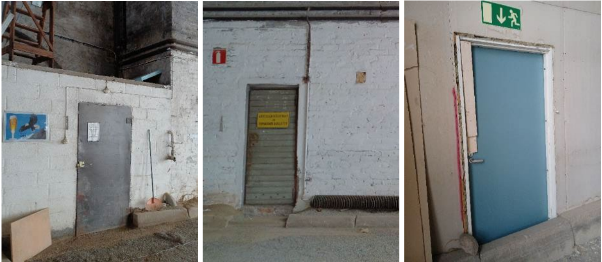
Kuva 98. Tilan ovia: Vasemmalla öljykattilahuoneen (tila 2) metalliovi. Keskellä todennäköisesti alkuperäinen, vaakapaneloitu ovi öljykattilahuoneeseen. Oikeanpuolimmaisessa kuvassa väliovi, joka johtaa viereiseen pilttuuseen (tila 6).
