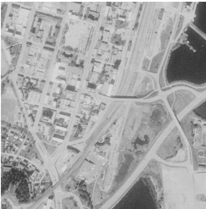
Kuva 15. Vuoden 1989 ilmakuvassa entiselle halkokentälle on tullut uudisrakennus ja pysäköintialue. Veturitallin ympäristössä olleet varistorakennukset on purettu. Alueen itäpuolelle on valmistunut Viitostie ja vesialue on umpeutunut. Lähde: Maanmittauslaitos Paikkatietoikkuna, Historialliset ilmakuvat.
