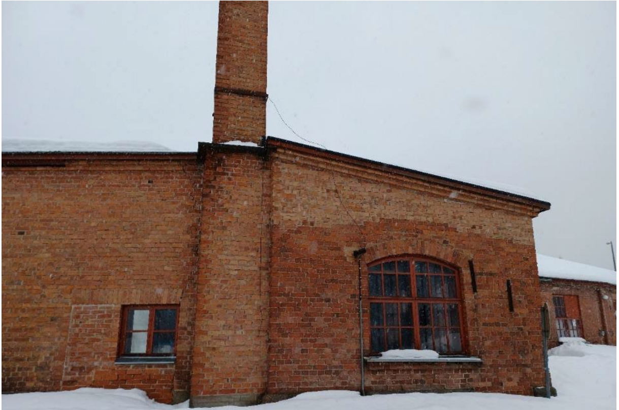
Kuva 44. Laajennusosan alku Ratakadun puolella rakennuksen itäpuolella. Pulpettikattoinen osa, jossa on kaari-ikkuna, on vuodelta 1908. Tilassa on ollut alun perin ilmeisesti sauna ja pesutilat, ja siinä on ollut harjakatto. Myöhemmin tässä tilassa on ollut pannuhuone. Tilaa on korotettu ja siihen on tehty pulpettikatto piipun rakentamisen ja kuvassa vasemmalla näkyvän 1940-luvun laajennuksen yhteydessä.
