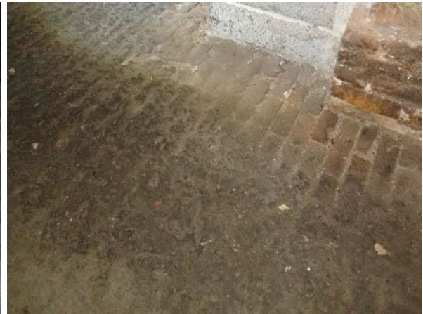
Kuva 86. Lattiapintoja: (vas. ylh.) tilojen 6 ja 7 laajennusosan lattia on betonia. Tilan perällä näkyy väliovi (19), joka johtaa tilaan 3. (vas. alh.) Alkuperäisen sekä laajennusosan rajakohta, jossa tiililattia vaihtuu betoniksi ja luonnonkivisokkeli niin ikään betoniksi. Kuvassa myös ripaputkipatteri. (oik. alh.) Punatiilistä ladottua lattiapintaa on kaikkien kolmen tilan vanhoissa osissa.
