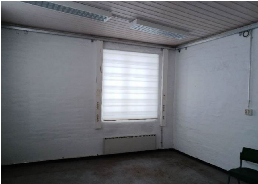
Kuva 64. Entiseen pajaan tehty toimistotila. Seiniä ei ole vuorattu, vaan alkuperäinen tiilipinta on maalattu valkoiseksi. Valaisimet ovat loisteputkivalaisimia.
