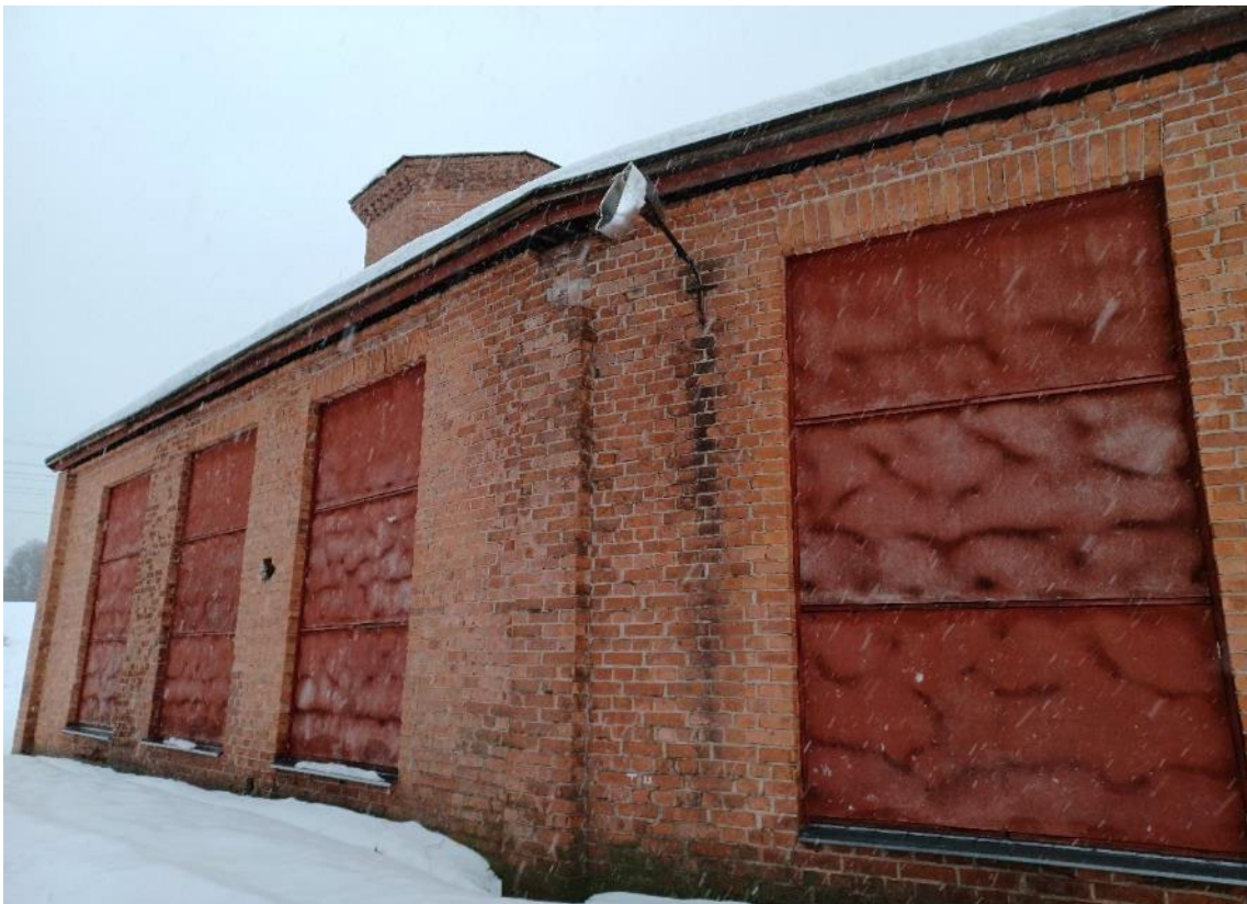
Kuva 43. Laajennusosan ikkunat on peitetty ilkvallan vuoksi.
