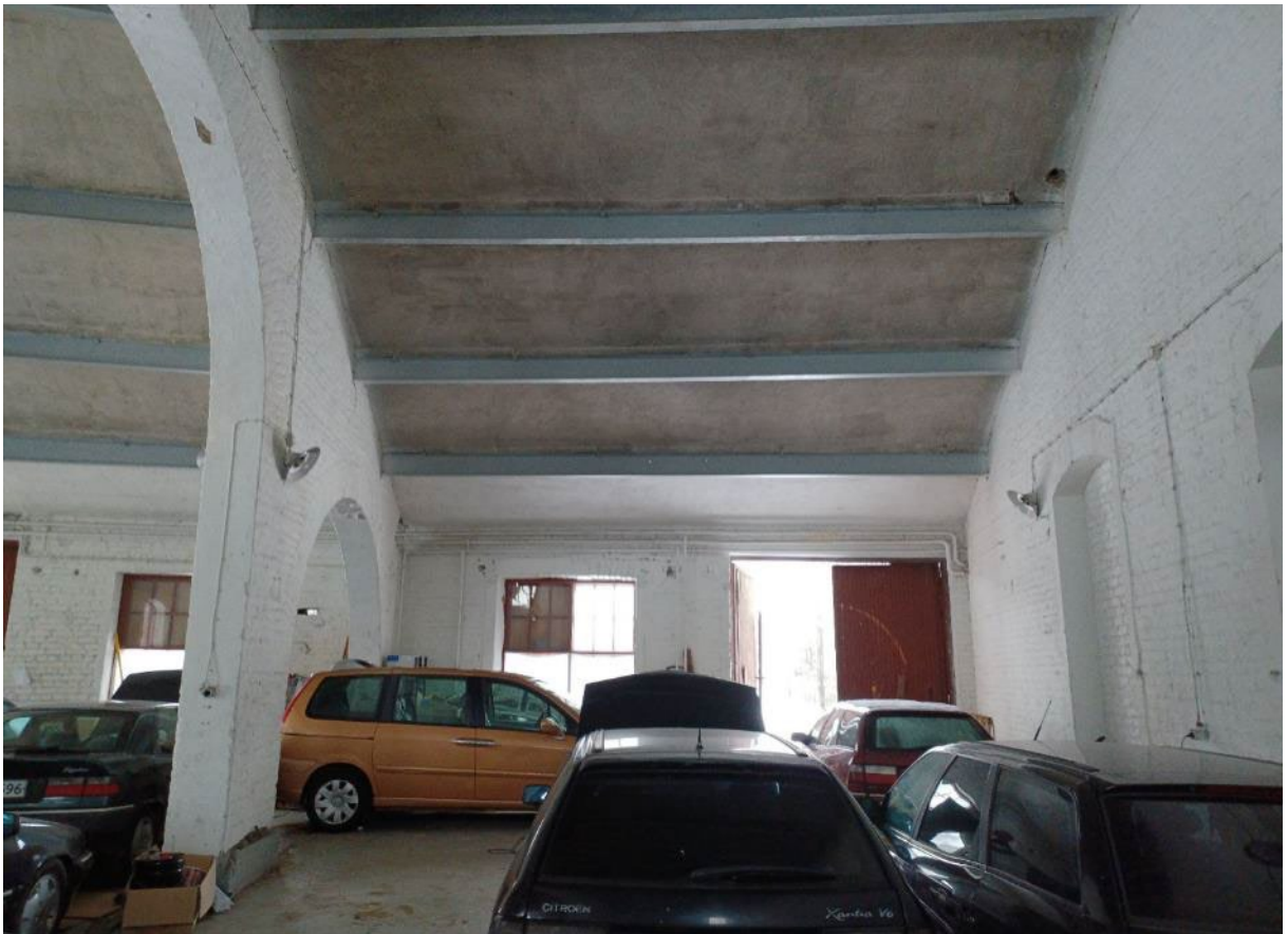
Kuva 104. Tila kuvattuna kohti toista sisäänkäyntiä (ovi 12).
