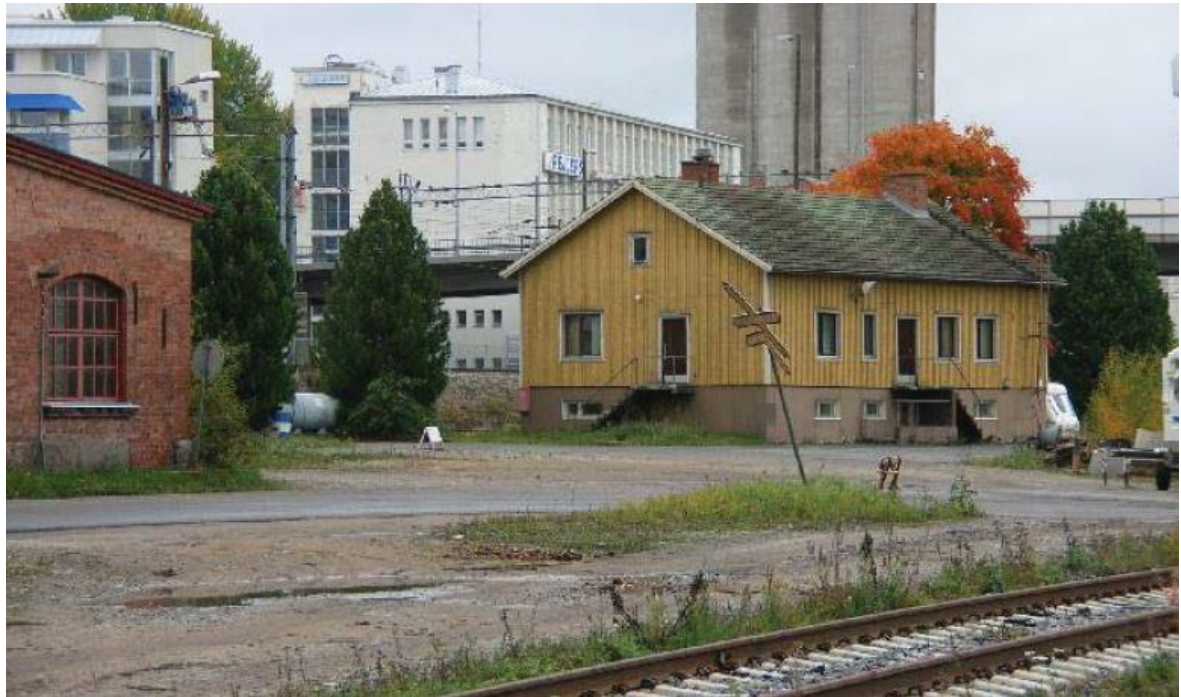
Kuva 16. VR:n vuonna 1951 rakennettu huoltorakennus (Petri Enqvist, 2006)
