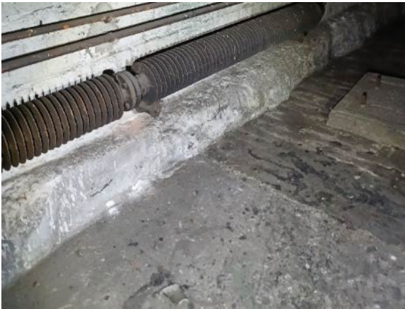
Kuva 86. Lattiapintoja: (vas. ylh.) tilojen 6 ja 7 laajennusosan lattia on betonia. Tilan perällä näkyy väliovi (19), joka johtaa tilaan 3. (vas. alh.) Alkuperäisen sekä laajennusosan rajakohta, jossa tiililattia vaihtuu betoniksi ja luonnonkivisokkeli niin ikään betoniksi. Kuvassa myös ripaputkipatteri. (oik. alh.) Punatiilistä ladottua lattiapintaa on kaikkien kolmen tilan vanhoissa osissa.
