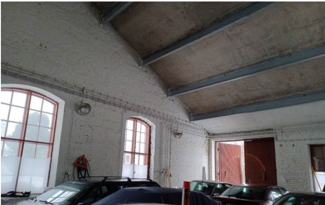
Kuva 107. Näkymä rakennuksen pohjoispäädystä kohti ovea 11.
