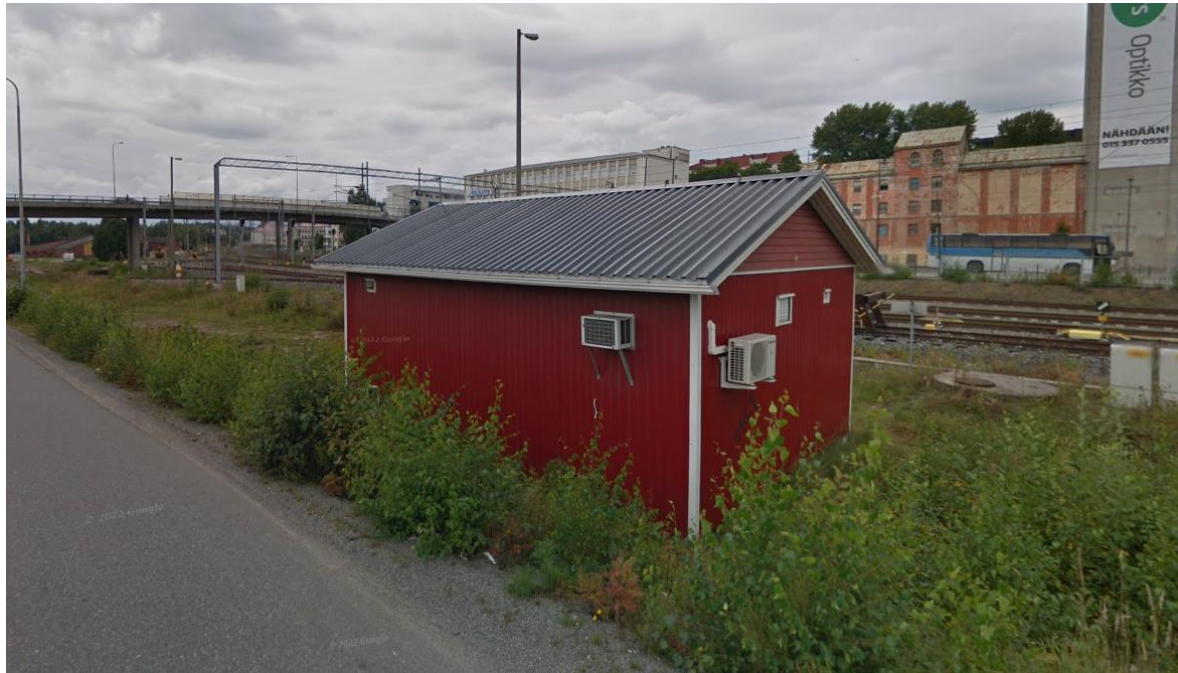
Kuva 17. Rautatiehen liittyvä sähkömuuntamo (Google 2011)
