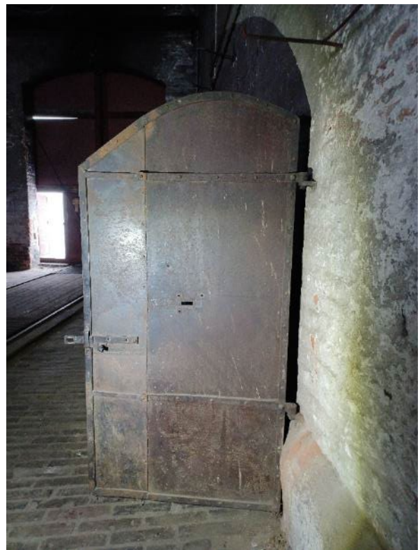
Kuva 78. Peiliovet 14, 15, 16 ja rautaovi 17 ovat kaikki tilassa nro 9. 14 ja 15 lienevät 1940-luvulta, kun taas 16 ja 17 lienevät rakennuksen ensimmäisen vaiheen ajalta, 1800-luvun lopulta.
